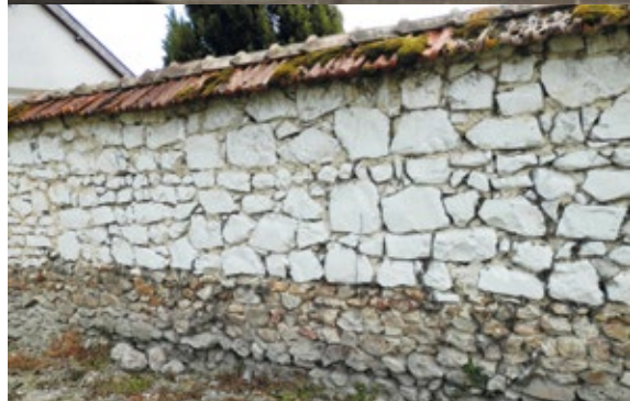
Mur en meulière et moellons de craie
