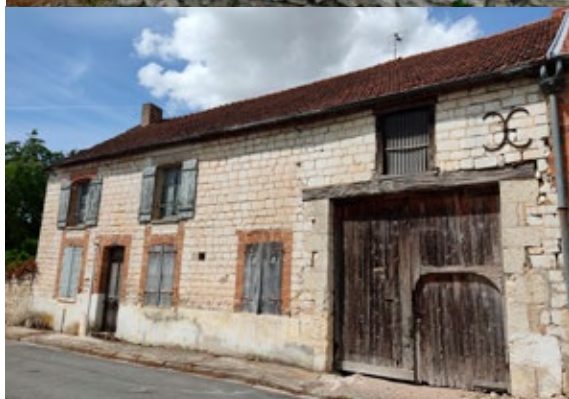
Construction en blocs de craie taillés, Bisseuil
