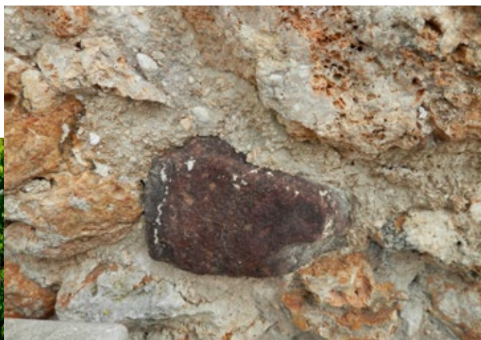
Moellons de grés ferrugineux dans une maçonnerie
