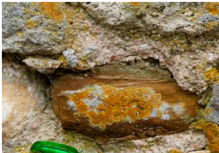
Moellons de grés ferrugineux dans une maçonnerie
