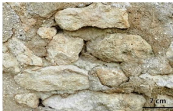
Construction en moellons calcaires, Jonquery
