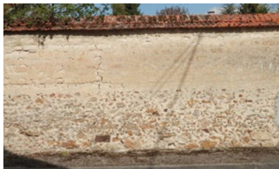
Mur en meulière et carreaux de terre
