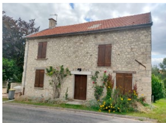
Construction en moellons calcaires, Jonquery
