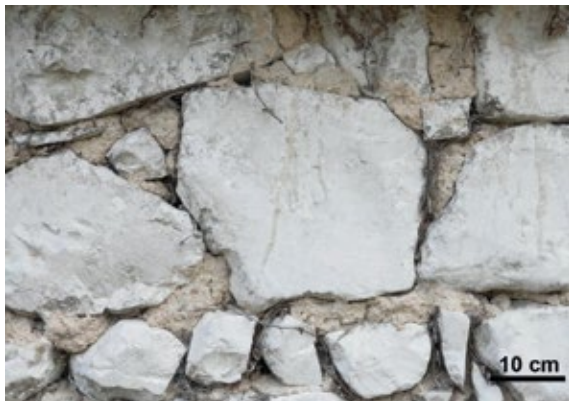
Moellons de craie maçonnés
