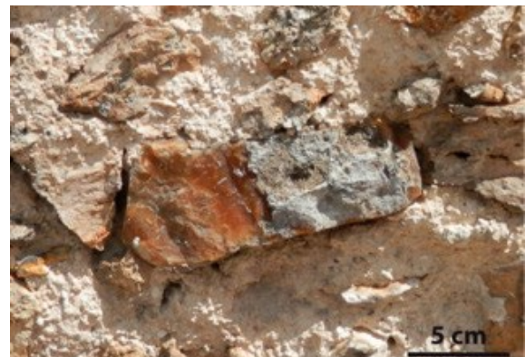
Meulière compacte en œuvre dans une maçonnerie
